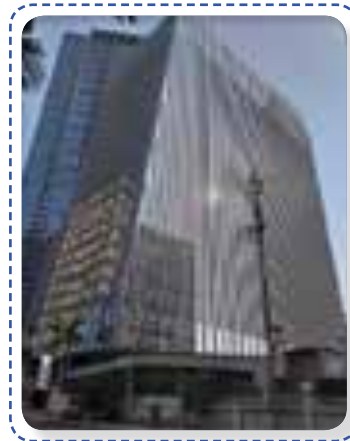
Sudirman 7.8 Green Building Gold Rank (50 points) / Peringkat Green Building Gold (Poin 50) Year 2016-2018 / Tahun Pelaksanaan 2016-2018
